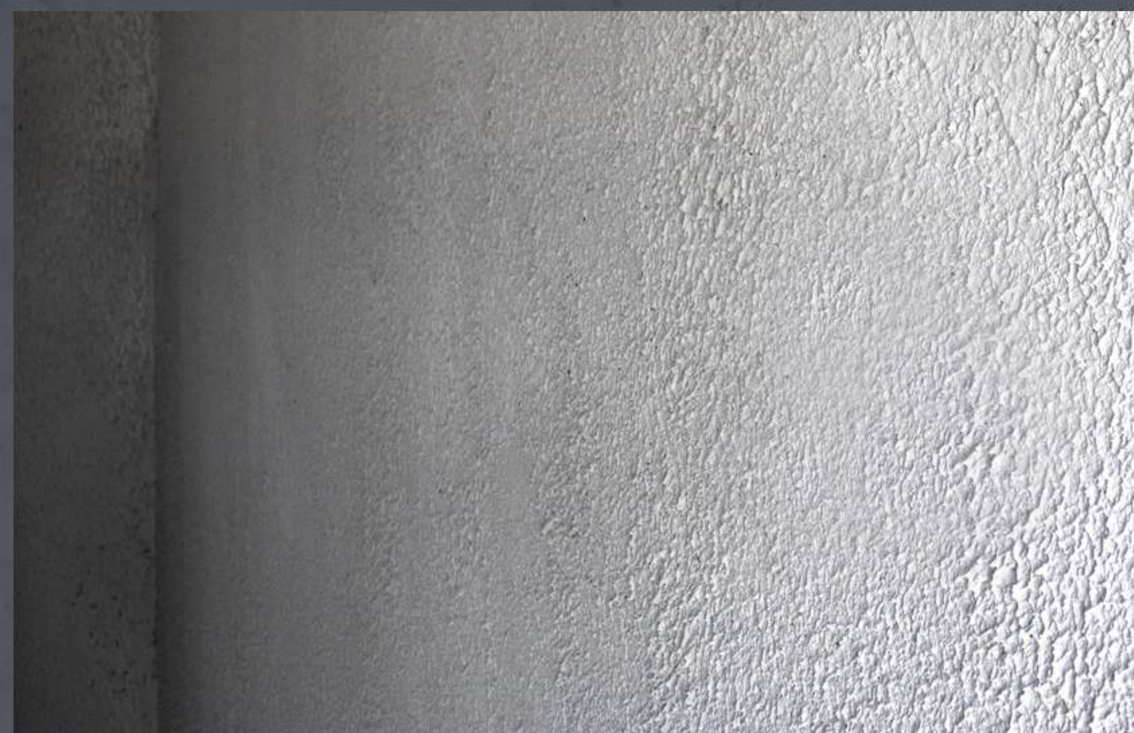
Aplicação de Argamassa Projetada
