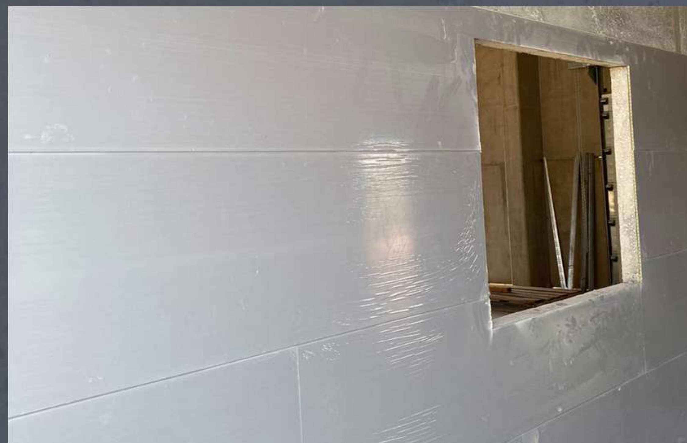
Instalação de Revestimento WPC
